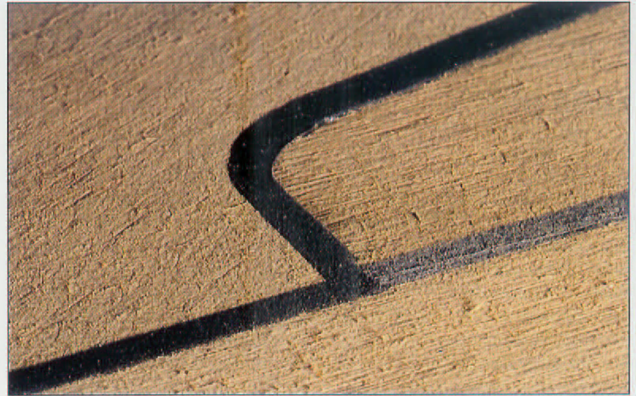
De l'art de joindre. Les lattes en PVC ont un joint noir intégré (à droite) alors que pour les découpes particulières, les joints sont à faire après (à gauche).
