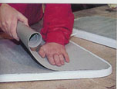
Les plaques de TBS se collent avec un mastic polyuréthane sur tous types de supports.
